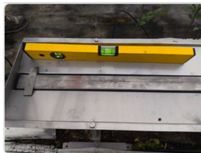
Comprobación del desnivel a lo largo
