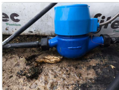
Raccordement à un tuyau adjacent (< 40 goutteurs)
