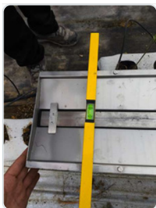
Nivellement de la largeur du plateau
